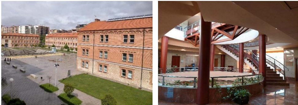
Fig. 1 Imágenes del Campus Viriato, vista general y espacio interior del edificio de la EPSZ
